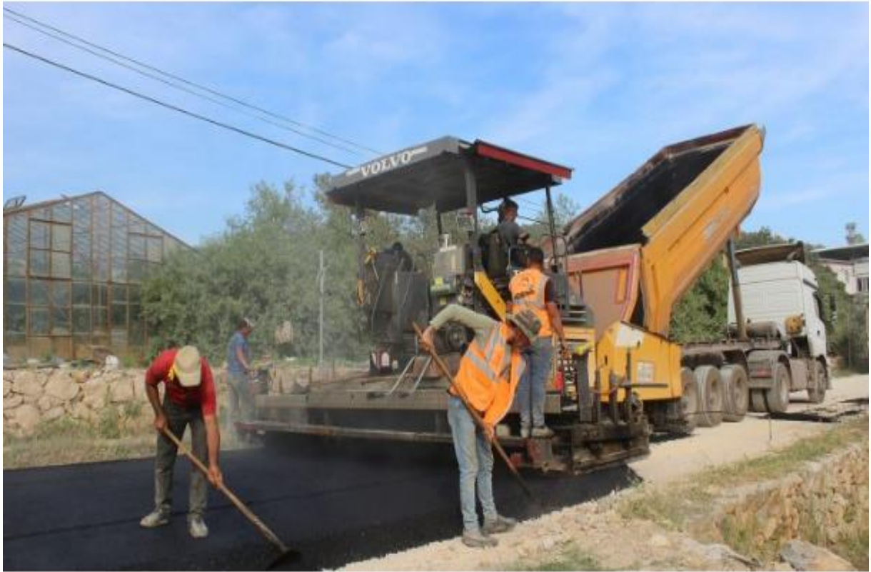
BÜYÜKŞEHİR GÜLNARIN BÜYÜKECELİ MAHALLE YOLUNU ASFALTLADI
